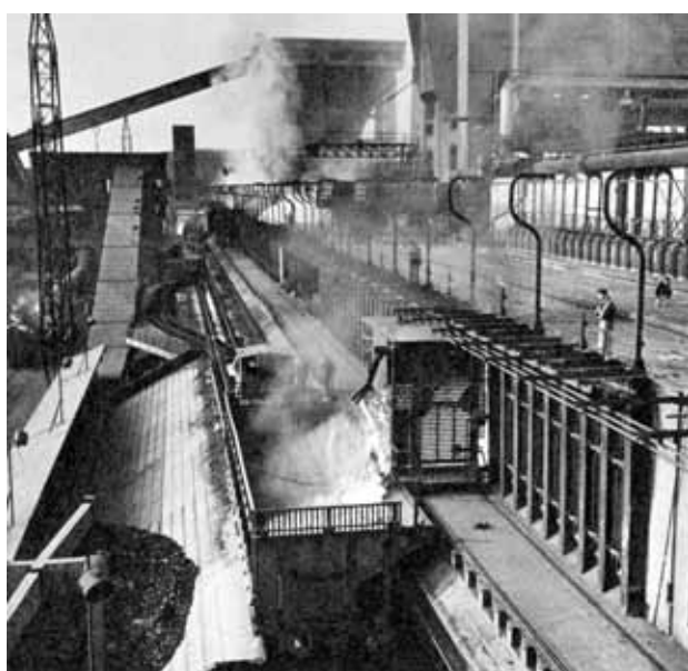
Figure 14: Discharging of red-hot coke Slika 14: Praznjenje žarečega koksa iz peći
